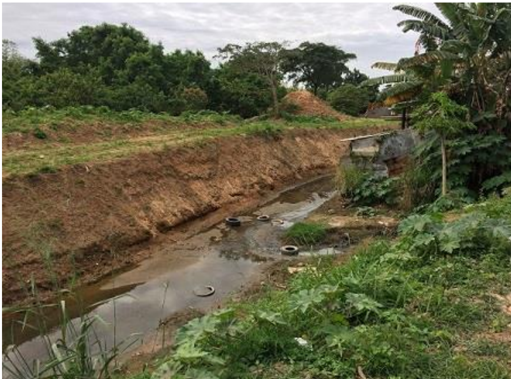
Foto 5 – Descarte irregular de resíduos em córrego no bairro Nova Almeida, Serra/ES
